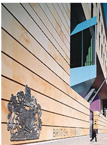
Embajada del Reino Unido en Berlín Situación: Berlín, Alemania Promotor: Ministerio Exteriores y Commonwealth Arquitecto: Michael Wilford and Partners Asesor: TPS Consult
