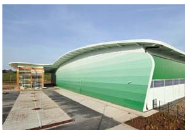
G PARK BLUE PLANET Situación: Newcastle-Under-Lyme, Reino Unido Promotor: Gazeley Arquitecto: Chetwoods Architects Asesor: Davis Langdon LLP
